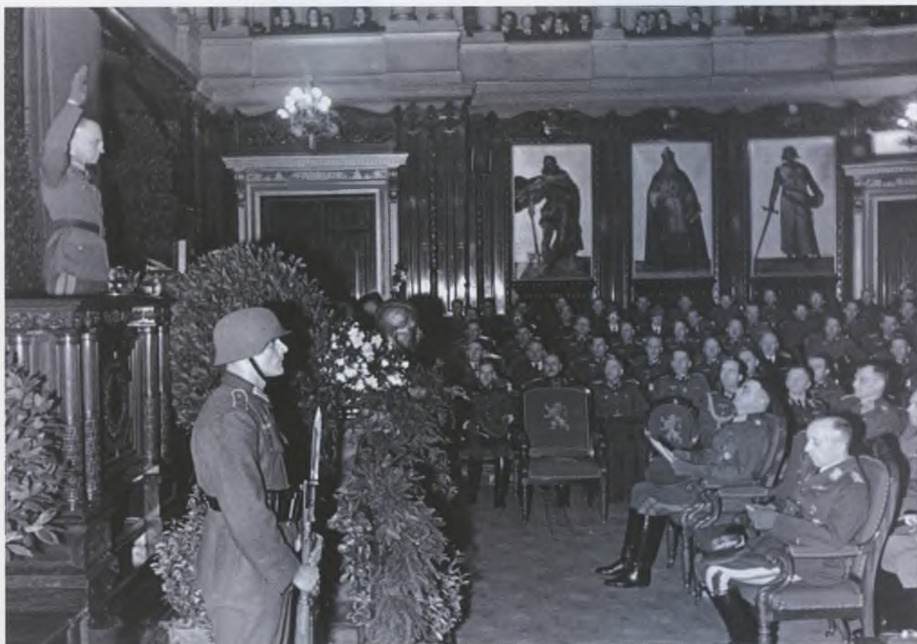
L'occupant investit les lieux symboliques. Ici le commandant du gouvernement militaire de l'Allemagne pour la Belgique et le nord de la France, le Général VON FALKENHAUSEN au Sénat lors d'une journée d'hommage aux « héros allemands », [16/3/1942] [Sipho], coll. CEGES
